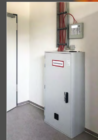
LX 30 Modulares Brandschutz-Standgehäuse
