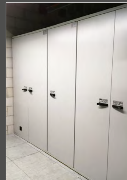
Violution Modus 90 Modulares Brandschutz-Überstülpgehäuse
